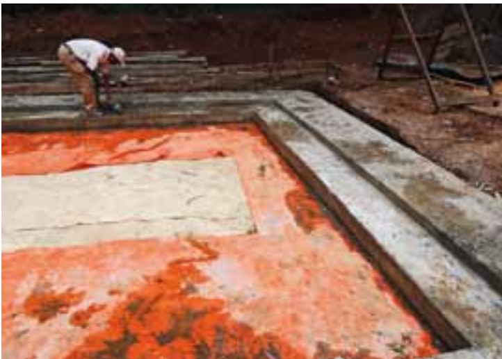
Das SUDU-Haus, hier das Fundament, wird demnächst von ETH-Studenten vervollständigt. (Bild: Aida Muluneh)
